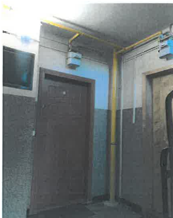
Przebudowa instalacji gazowej w budynku przy ul. Gałczyńskiego 2
