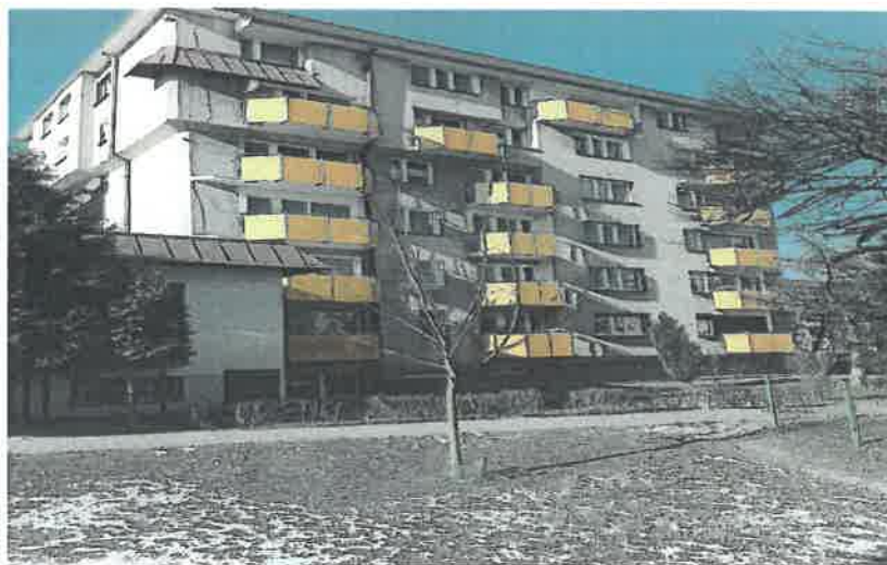
Wyremontowane balkony w budynku przy ul. Modrzewiowej 13
