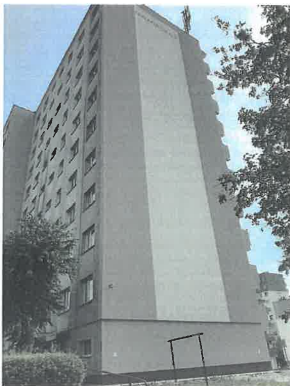
Ocieplenie budynku przy ul. Gwareckiej 3
