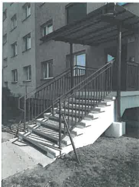
Remont wejść do budynku przy ul. Brodzińskiego 1
