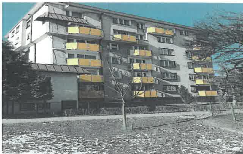
Wyremontowane balkony w budynku przy ul. Modrzewiowej 13
