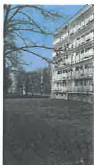
Wyremontowane balkony ul. Makuszyńskiego 11
