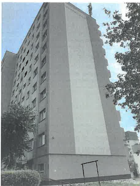
Ocieplenie budynku przy ul. Gwareckiej 3
