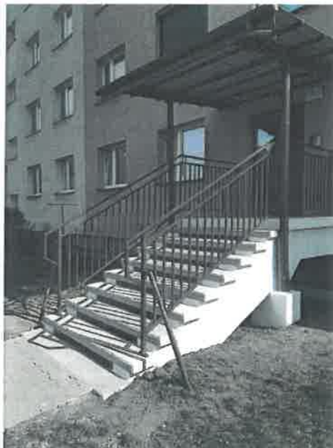
Remont wejść do budynku przy ul. Brodzińskiego 1
