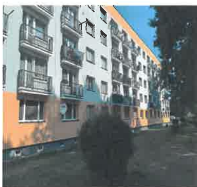
Docieplenie ściany podłużnej przy ul. Kłodnickiej 62÷62C
