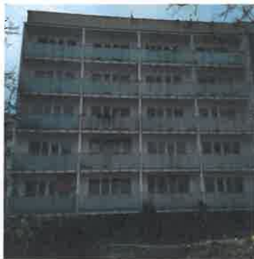
Wyremontowane balkony w budynku przy ul. Brodzińskiego 5, 5A
