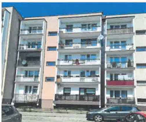
Wyremontowane balkony w budynku przy ul. Leśnej 40B,C
