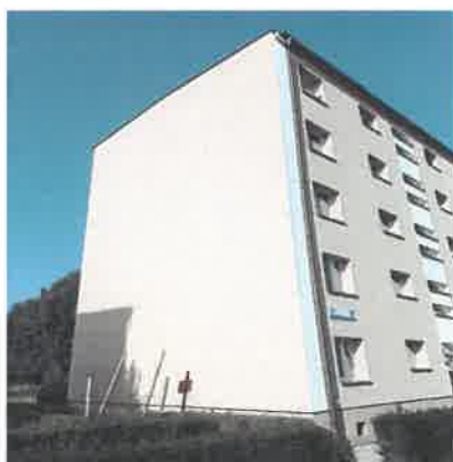
Renowacje ściany szczytowej budynku przy ul. Międzybłokowa 10
