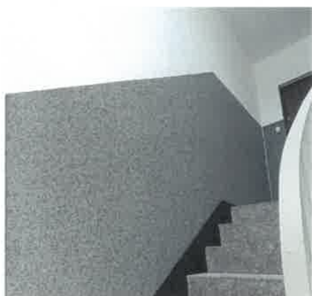
Wyremontowane klatki schodowe w budynku przy ul. Leśnej 2
