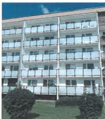
Wyremontowane balkony w budynku przy ul. Kosynierów 2F
