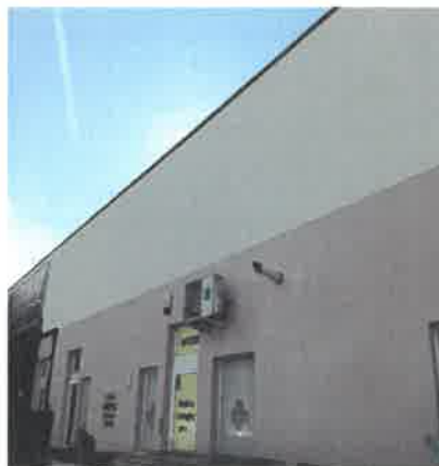
Remont ściany pawilonu przy ul. Makuszyńskiego 5
