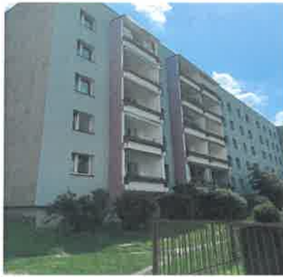
Docieplenie budynku przy ul. Modrzewiowej 2
