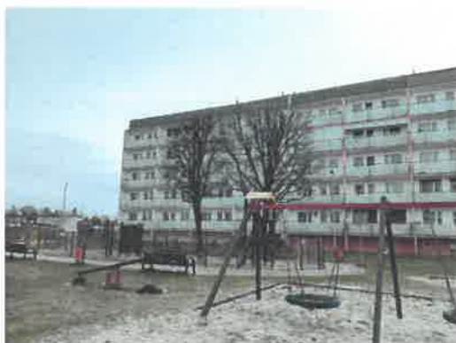
Wyremontowane balkony w budynku przy ul. Raławickiej 3E
