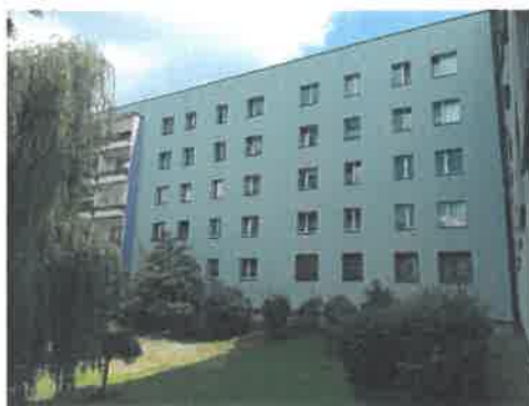
Docieplenie budynku przy ul. Modrzewiowej 4,4A
