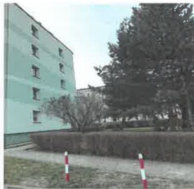
Renowacja ściany szczytowej budynku przy ul. Solidarności 16
