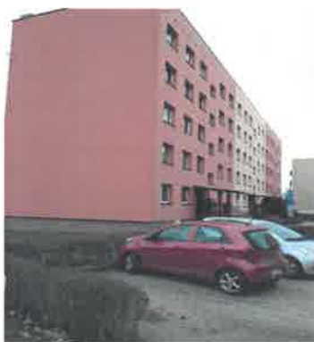
Renowacja elewacji frontu budynku wraz z wzmocnieniem ściany szczytowej ul Brzechwy 13
