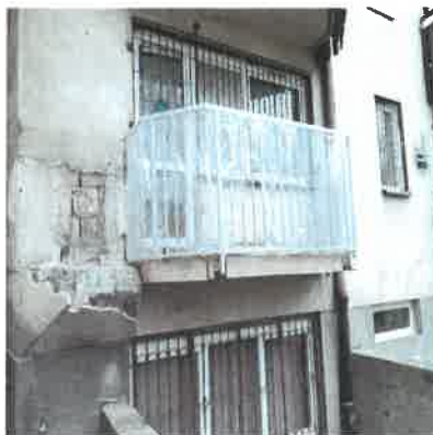
Remont balkonu w budynku przy ul. Modrzewiowa 9,13
