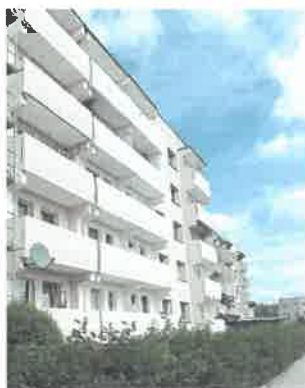
Wyremontowane balkony budynku przy ul. Sztolniowa 9, 9A
