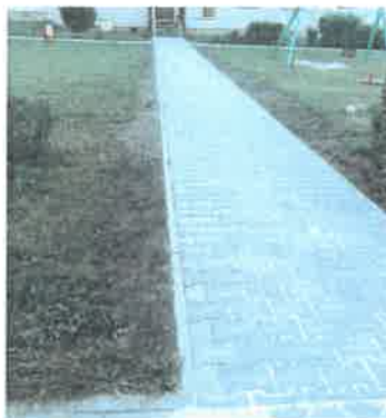
Remont chodników od frontu budynku przy ul. Brodzińskiego 1-1C
