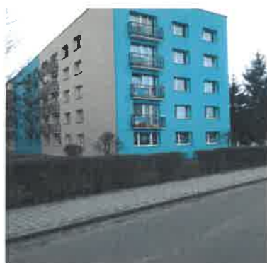
Oczyszczona i wzmocniona elewacja budynku przy ul. Kłodnickiej 68 B
