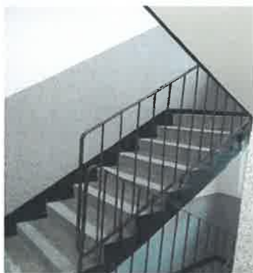
Wyremontowane klatki schodowe w budynku przy ul. Brzechwy 11
