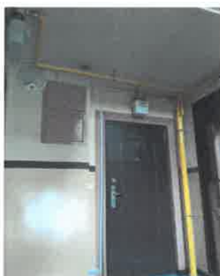
Wymieniona instalacja gazowa w budynku przy ul. Brzechwy 5
