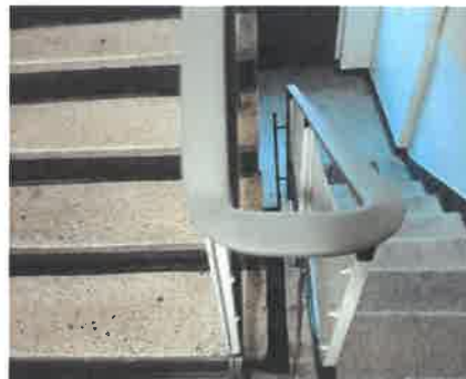
Montaż nakładki PCV na balustradach w budynkach przy ul. Międzybłokowej 8 i ul Międzybłokowej 10
