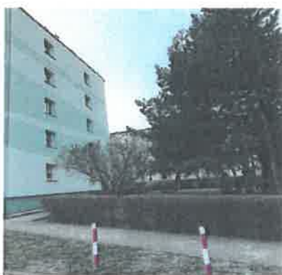
Renowacja ściany szczytowej budynku przy ul. Solidarności 16
