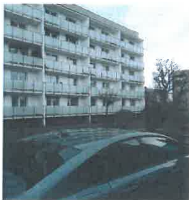
Wyremontowane balkony w budynku przy ul. Makuszyńskiego 9, 9A
