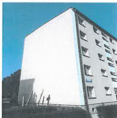
Renowacje ściany szczytowej budynku przy ul. Międzybłokowa 10
