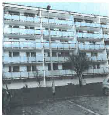
Wyremontowane balkony w budynku przy ul. Kosynierów 4F
