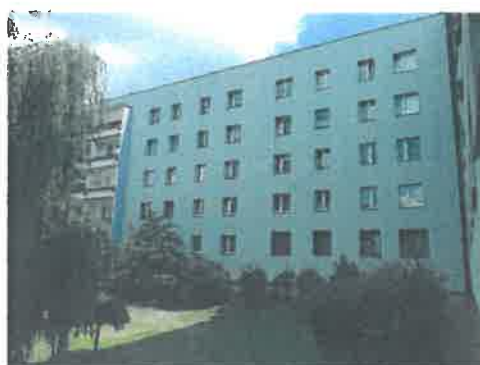
Docieplenie budynku przy ul. Modrzewiowej 4,4A
