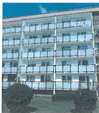
Wyremontowane balkony w budynku przy ul. Kosynierów 2F
