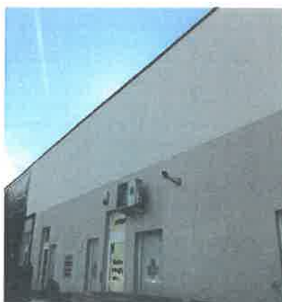
Remont ściany pawilonu przy ul. Makuszyńskiego 5
