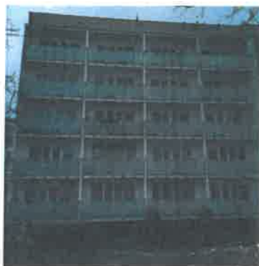
Wyremontowane balkony w budynku przy ul. Brodzińskiego 5, 5A
