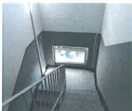
Wyremontowane klatki schodowe w budynku przy ul. Leśnej 4
