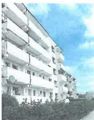
Wyremontowane balkony budynku przy ul. Sztolniowa 9, 9A
