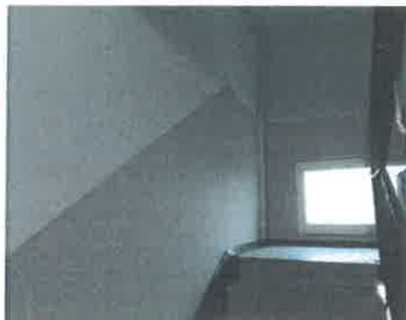
Wyremontowane klatki schodowe w budynku przy ul. Leśnej 14
