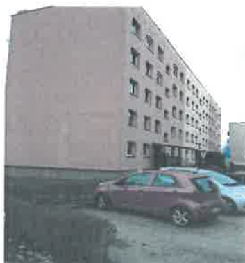
Renowacja elewacji frontu budynku wraz z wzmocnieniem ściany szczytowej ul Brzechwy 13
