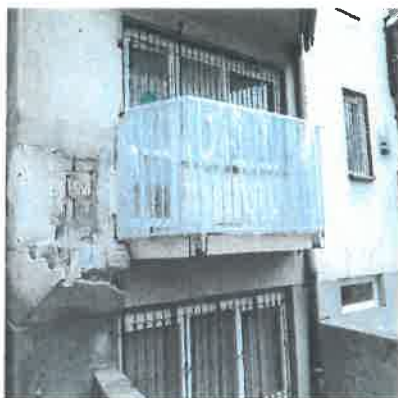
Remont balkonu w budynku przy ul. Modrzewiowa 9,13
