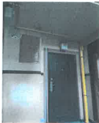
Wymieniona instalacja gazowa w budynku przy ul. Brzechwy 5
