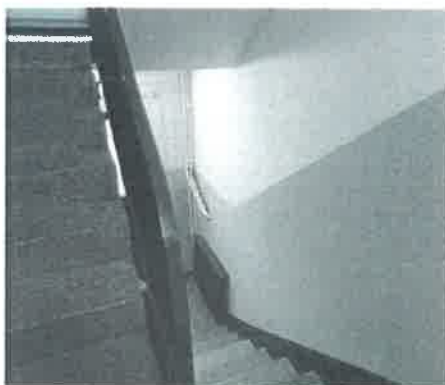
Wyremontowane klatki schodowe w budynku przy ul. Leśnej 12
