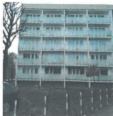
Wyremontowane balkony w budynku przy ul. Brodzińskiego 3, 3A
