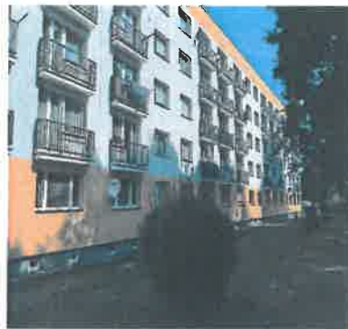
Docieplenie ściany podłużnej przy ul. Kłodnickiej 62÷62C
