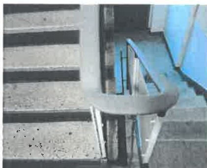
Montaż nakładki PCV na balustradach w budynkach przy ul. Międzyblokowej 8 i ul Międzyblokowej 10
