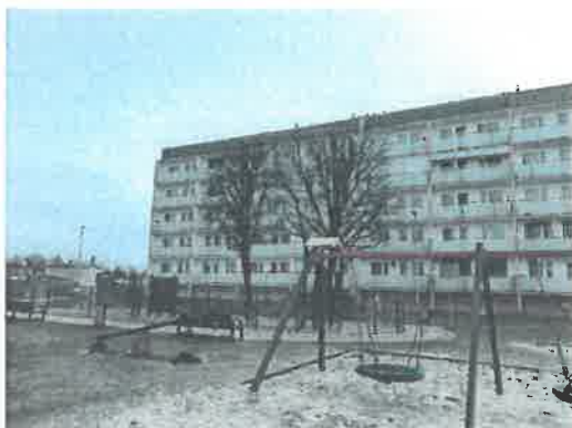
Wyremontowane balkony w budynku przy ul. Raclawickiej 3E
