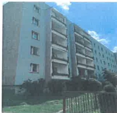
Docieplenie budynku przy ul. Modrzewiowej 2
